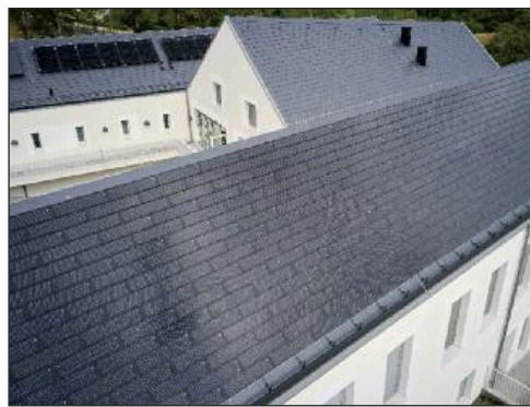
Die eingesetzten Fotovoltaik-Module fügen sich bündig in das vorhandene Verlegeraster ein.
