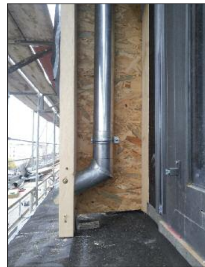
Das Bild aus der Bauphase vermittelt einen Eindruck, wie weit die Bekleidung vor dem Rohbau montiert wurde. Im entstehenden Freiraum verläuft das verdeckt liegende Fallrohr.
