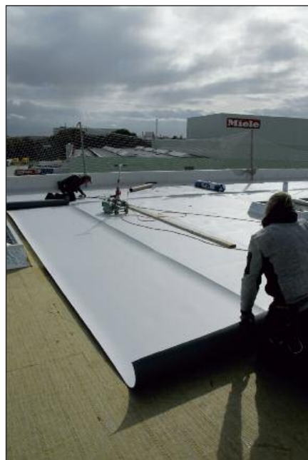
Altes Industriedach mit der schwarzen Sanierungsbahn WOLFEN GWSK saniert.
