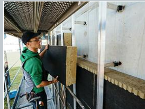
Erfüllen alle Anforderungen und sind leicht zu verarbeiten: Die mit schwarzem Schutz-Glasvlies kaschierten Fassaden-Dämmplatten ULTIMATE FSP-034 von ISOVER.
