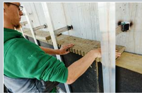
Die 300 mm starken Brandriegel wurden auf 240 mm Dämmstärke reduziert. Die Hinterlüftungsebene der Fassade von 40 mm wird vollständig ausgefüllt.
